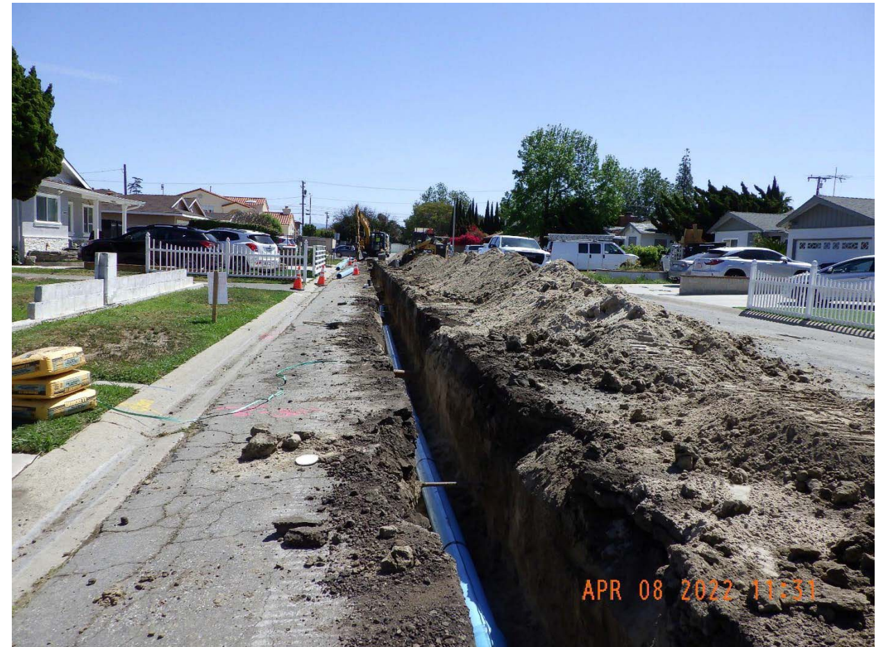
Thay thế Ống dẫn nước Chính Alwood Ave-Anthony Ave
