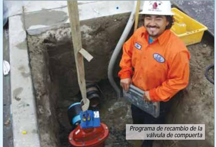
Programa de recambio de la válvula de compuerta
