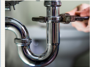
Đường ống nước
